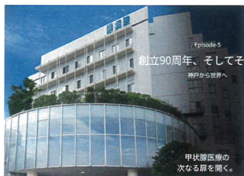
増改築工事が完了した隈病院
